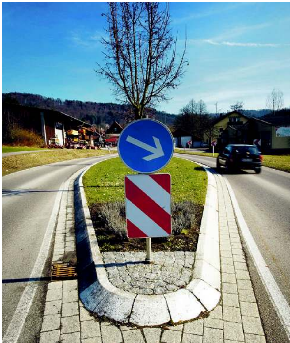
Mittelseln wie diese hier in Klaffenbach sollen auch in Rudersberg künftig Autos bremsen und den Lärm reduzieren.
