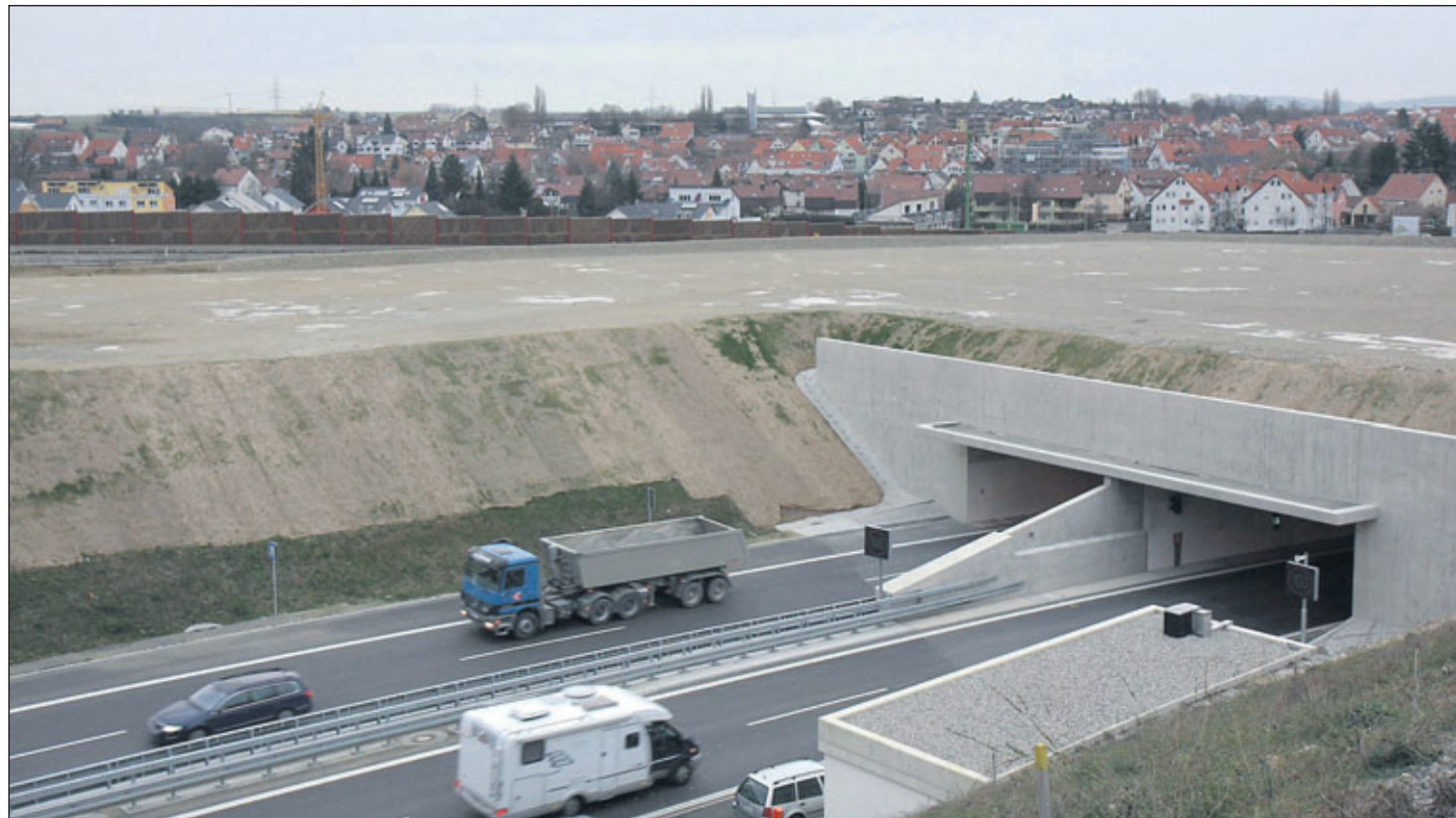
An den Tunnelportalen macht sich der Verkehrslärm besonders störend bemerkbar.
