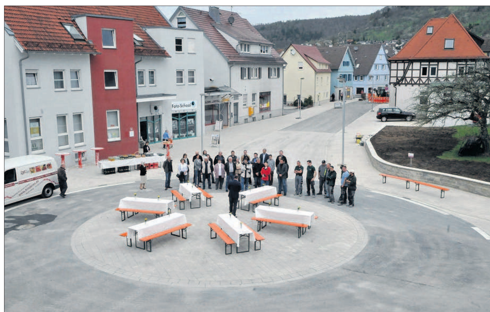
Außergewöhnlich menschenfreundliches Bild einer Kreisstraße: umgestaltete Rudersberger Ortsdurchfahrt mit Schrägpflaster auf dem Kreisel, der mit Weißwurstfrühstück eingeweiht wurde. Bilder: Schlegel
