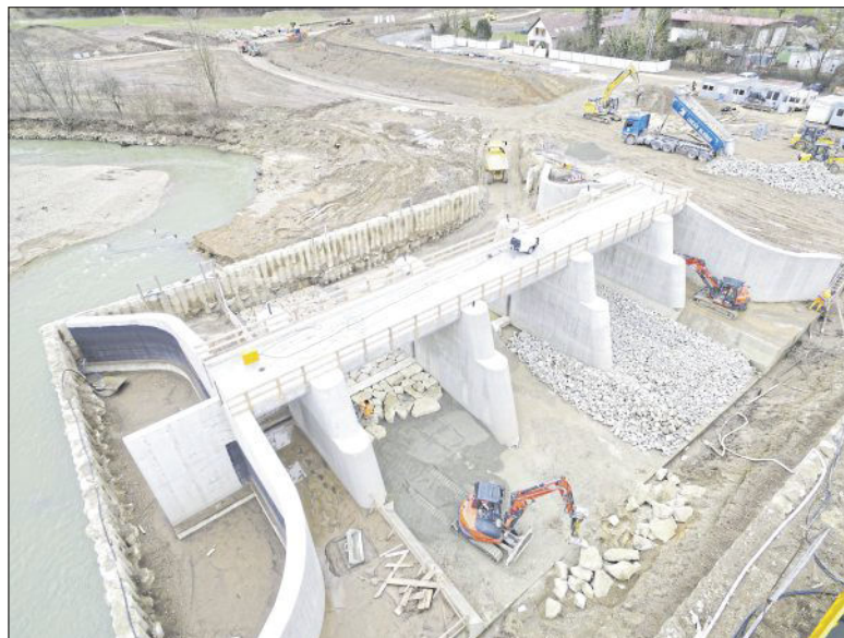
Das Rückhaltebecken 4 in der Bauphase - nun sind die Arbeiten fast fertig.
