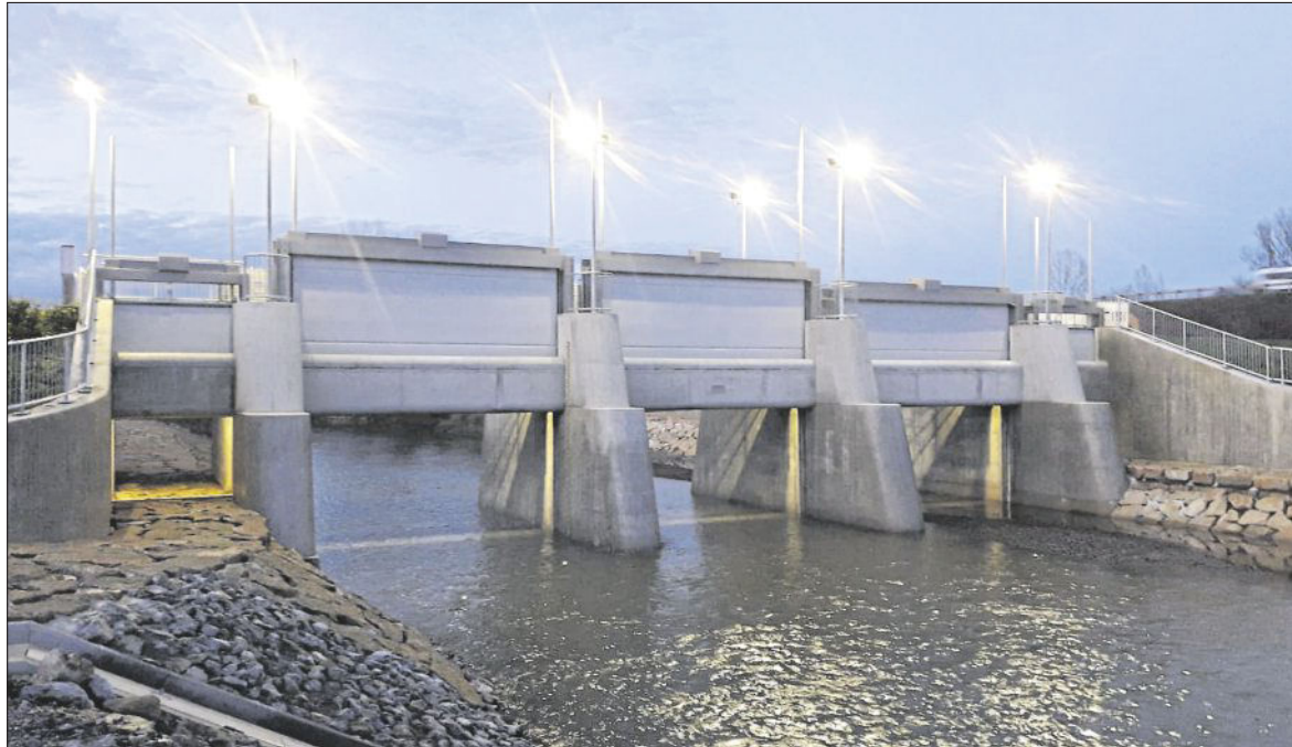
Das neue Rückhaltebecken 4 bei Plüderhausen war im Dezember einstaubereit. Die Planungen für das Becken 5 zwischen Schorndorf und Urbach liegen indes erst einmal für die nächsten drei Jahre auf Eis. Fotos: Privat / Ingenieurbüro Wald+Corbe
